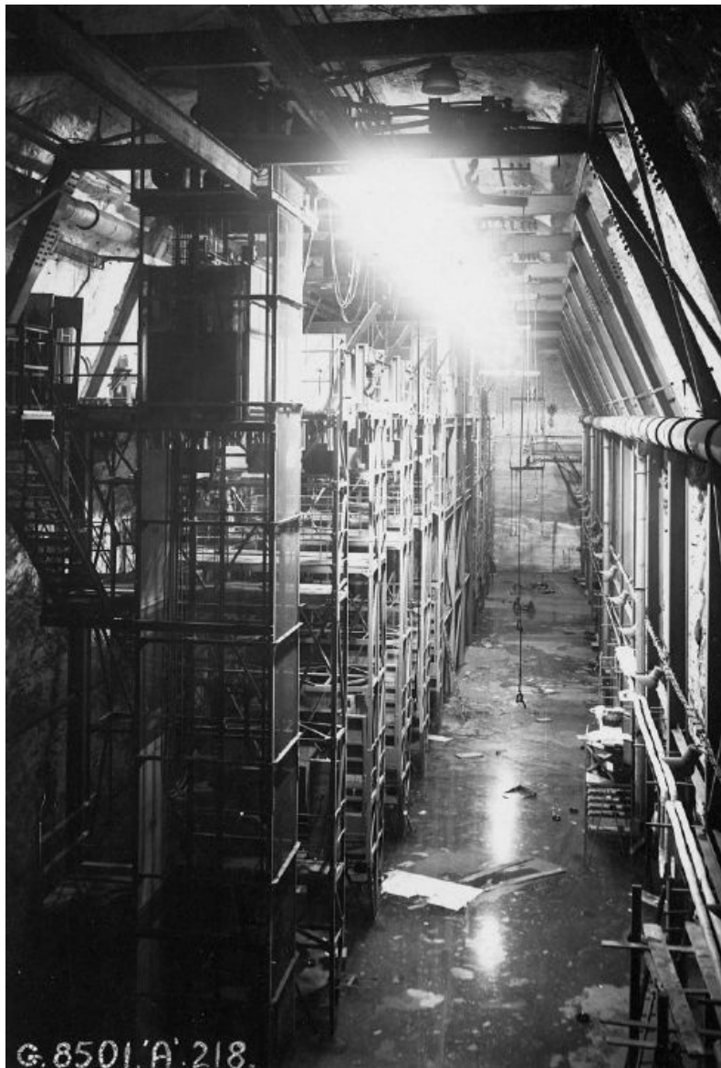
33. Vista de unos de los túneles principales de Mittelwerk.
